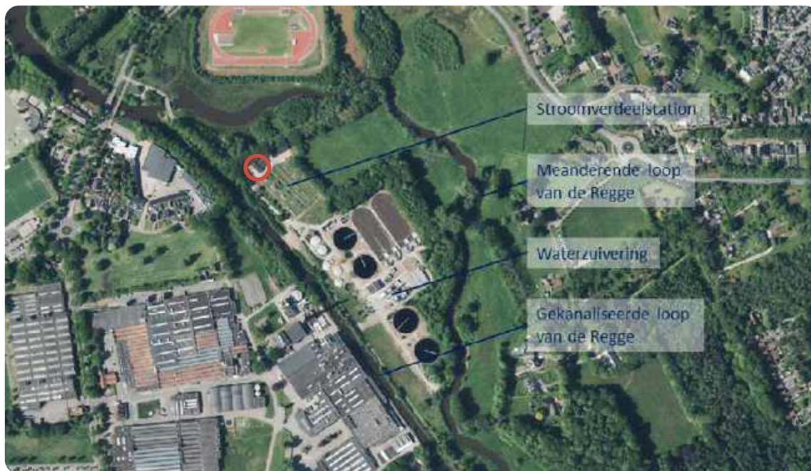
Figuur 8: Luchtfoto stroomverdeelstation Nijverdal en omgeving (bron: Klimateffectatlas). Het stroomverdeelstation ligt naast de waterzuivering op een 'eiland' tussen de Midden Regge en de 'nieuwe' Regge. De rode cirkel geeft het gebouw aan waar de stroomstoring plaatsvond.
