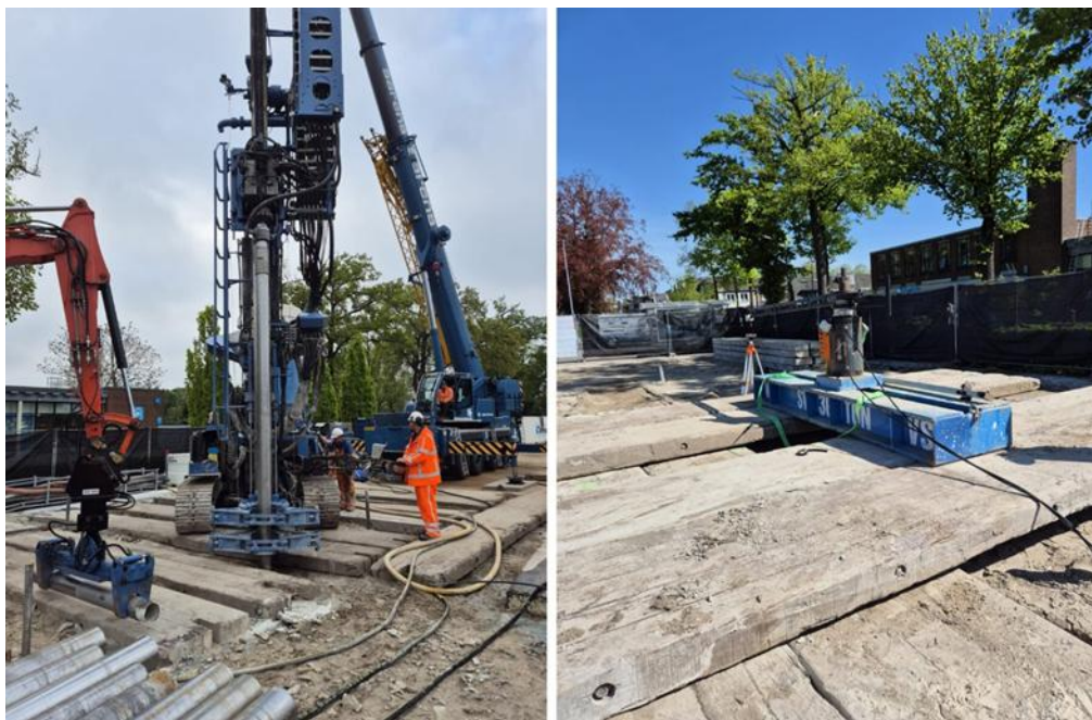
Ankerpalen bezwijkproef voor Tunnel
