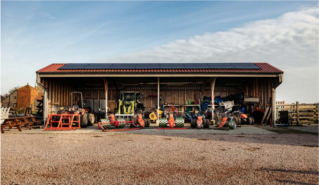
Werklocatie Veenweiden gebied met zonnepanelen op de kapschuur
